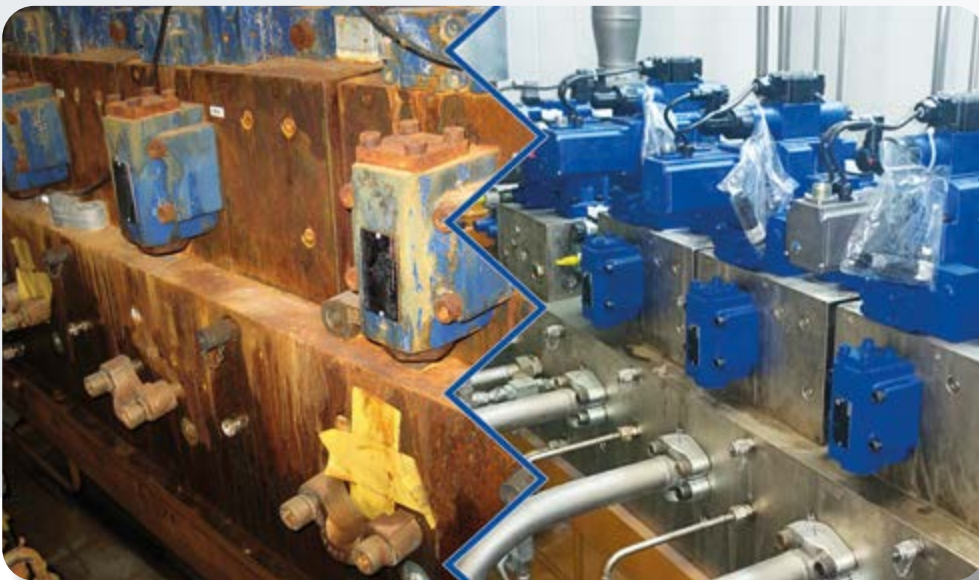
Instandsetzung und Reparatur eines Hydrauliksystems in kürzester Zeit.
