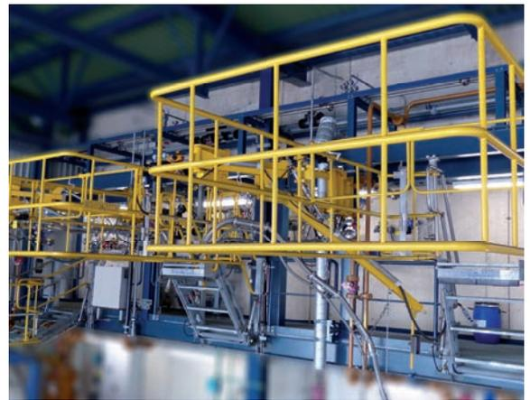
Schutzkörbe mit verriegelbarer Sicherheitsklapptür
